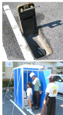
【マンホールトイレ】
